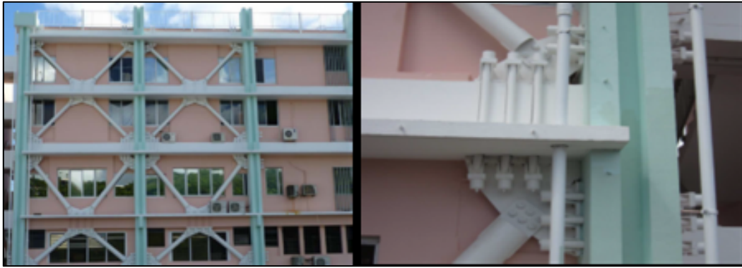
Photos de la structure exosquelette du bâtiment existant.
